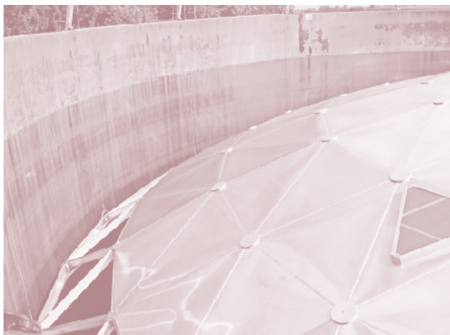
Tirage vers le haut du toit en aluminium
