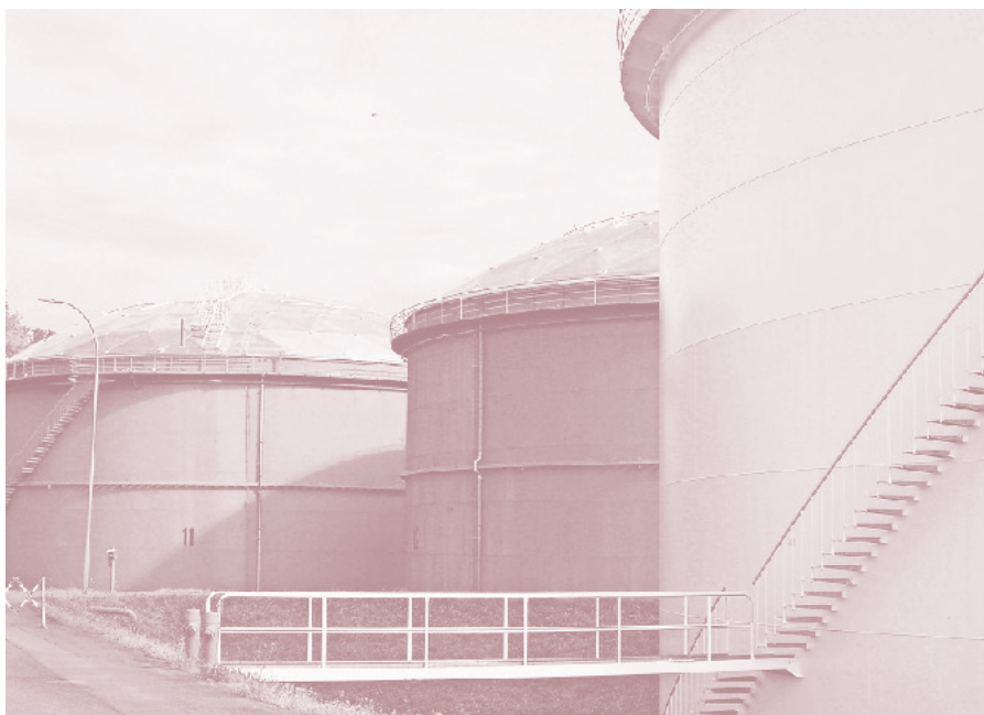
Toit en aluminium entièrement assemblé sur le réservoir de kérosène
