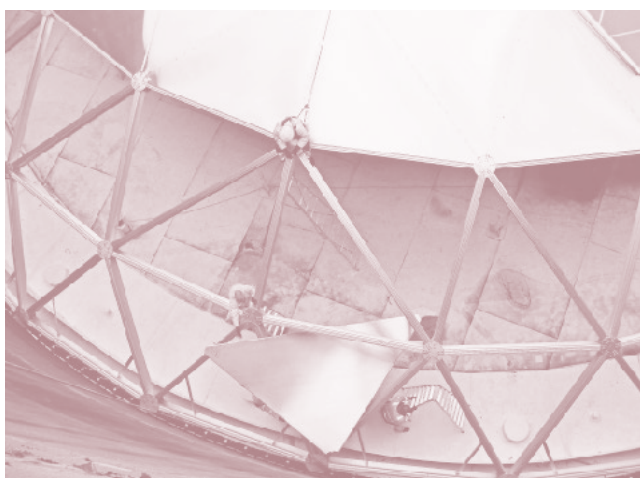
Montage d'un toit en aluminium
