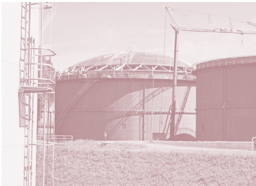
Montage d'un toit en aluminium sur le réservoir
