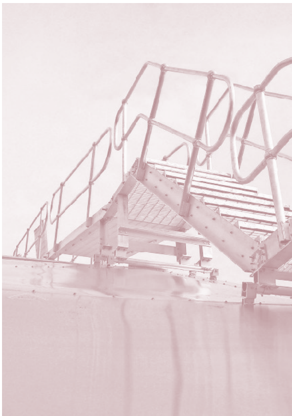
Accès au toit du réservoir
