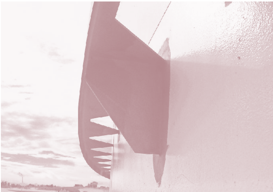
Renforcement du manteau de réservoir
