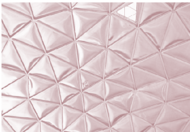
Aperçu du toit en aluminium à l'intérieur du réservoir
