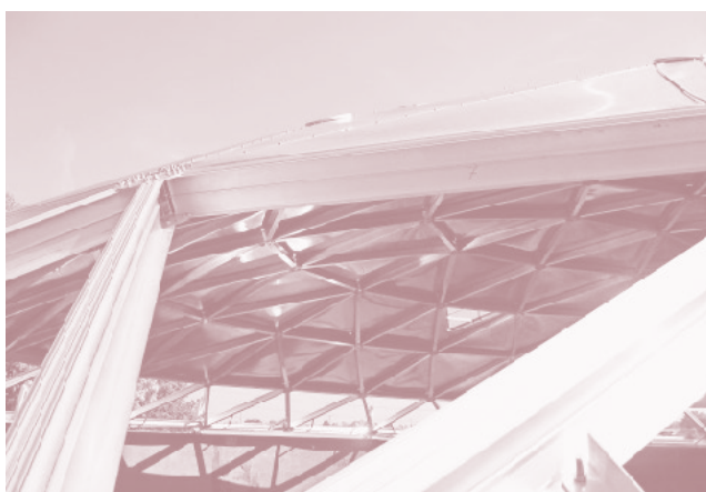
Partie d'un toit en aluminium
