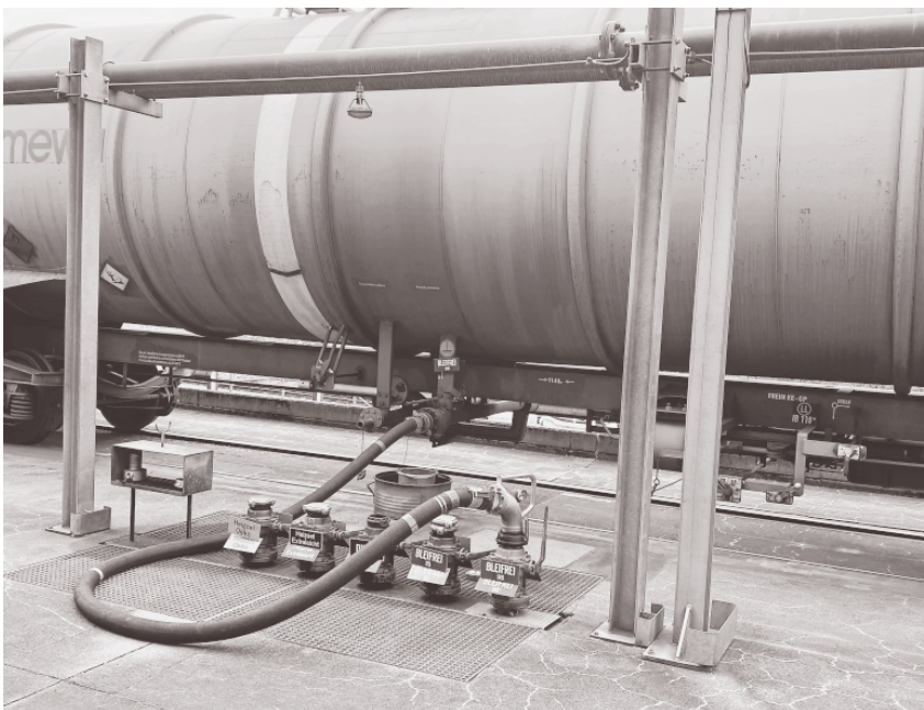
Entleerung Bahn-Zisternenwagen im Tanklager Mellingen, in Mellingen
