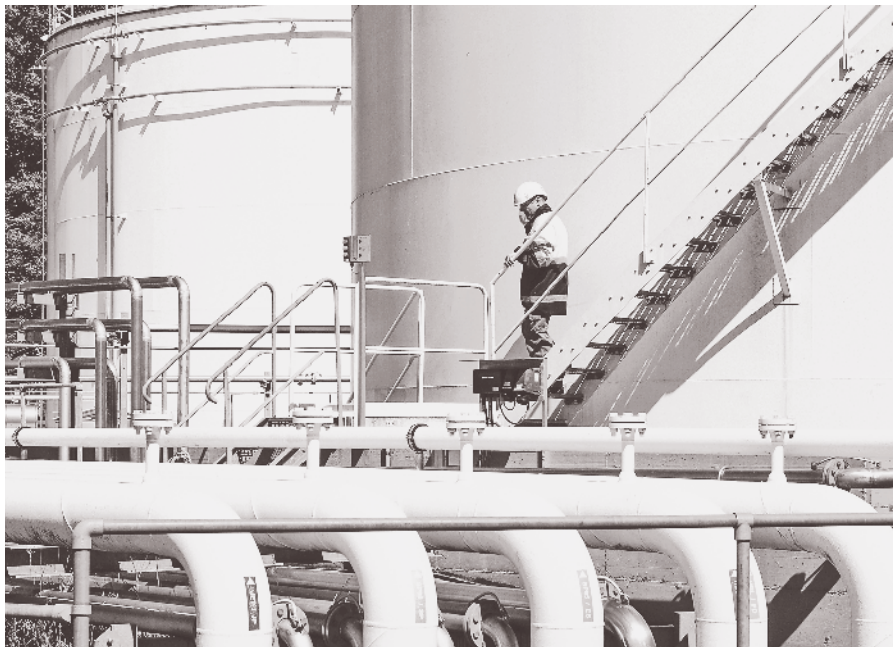
Tanks für die vorübergehende Lagerung von Mischprodukten aus der Multipipeline bei der Sapporo SA, in Vernier
