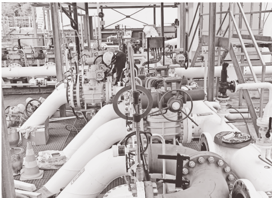
Verteilerbatterie bei der Sapporo SA, in Vernier
